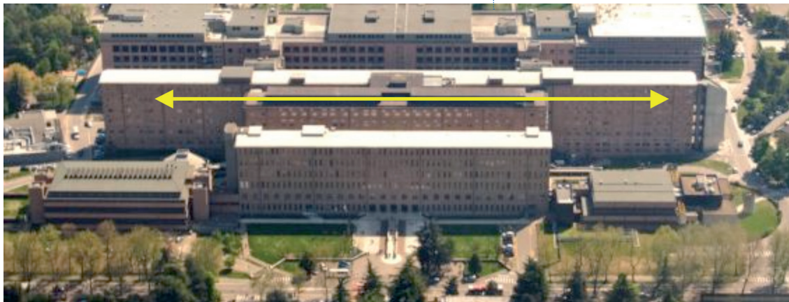
Il quarto piano del corpo C dell'Ospedale Santa Maria Nuova.
